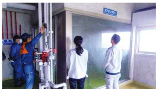
● スプリンクラー設備の見学
