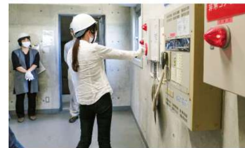
● 自動火災報知設備の見学
