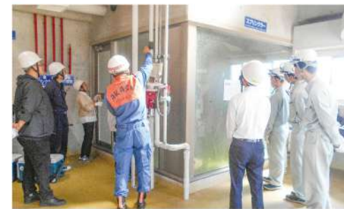
● スプリンクラー設備の見学
